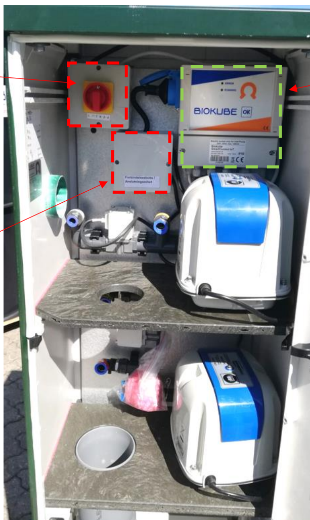
El- og kabeltilslutningspunkter i det eksterne teknikskab
