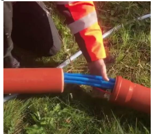
Trækning af luftslanger og kabler i 110 mm føringsrør, før nedgravning af trækrør. Kan også gøres efter nedgravning via træksnor.
