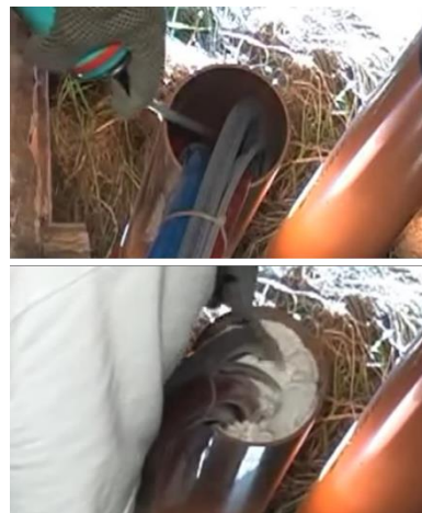
Skumning af føringsrør ved teknikkasse, for at gøre dette lufttæt
