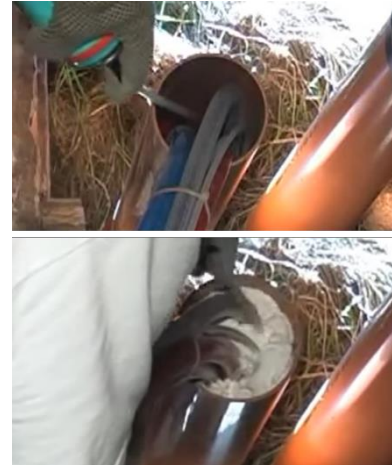
Skumning af føringsrør ved teknikkasse, for at gøre dette lufttæt
