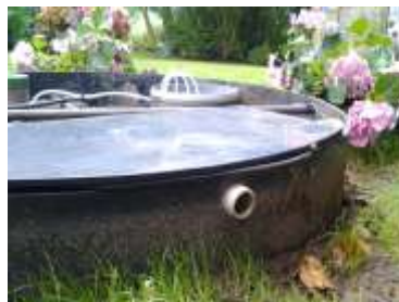
Udluftning af teknikkasse må ikke anvendes til gennemføring af kabel.
