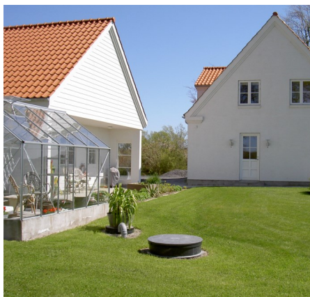
Pluto installeret ved et enfamilieshus
