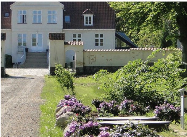
Projekt: Marjatta 80 PE. Kunde: Marjatta Kapacitet: 80 PE, SOP. Installationsår: 2011
